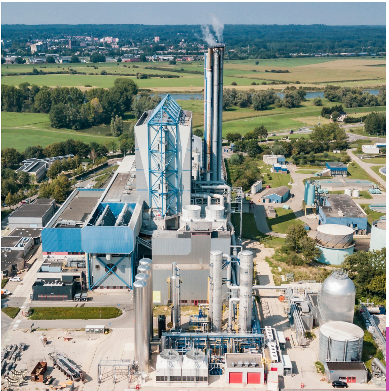
AVR EGA jėgainė (antrame plane) ir CO 2 surinkimo blokas (pirmame plane) Duivene, Nyderlanduose. © AVR Afvalverwerking B.V.
